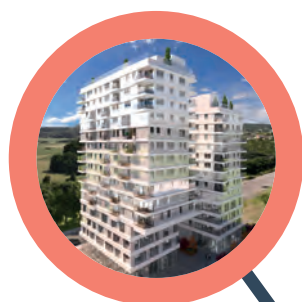
2014 LES CAPELLI TOWERS Un quartier vertical avec son jardin au 14 ème étage au Luxembourg
