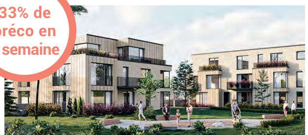
DIFFERDANGE (LUX) - CITÉ ANDROMÈDE 39 logements - 5 500€/m 2
