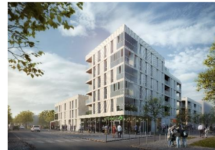
Aménagement de la ZAC Intercampus – Amiens (80)
